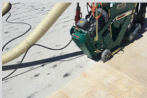
KUGELSTRAHL- ARBEITEN
